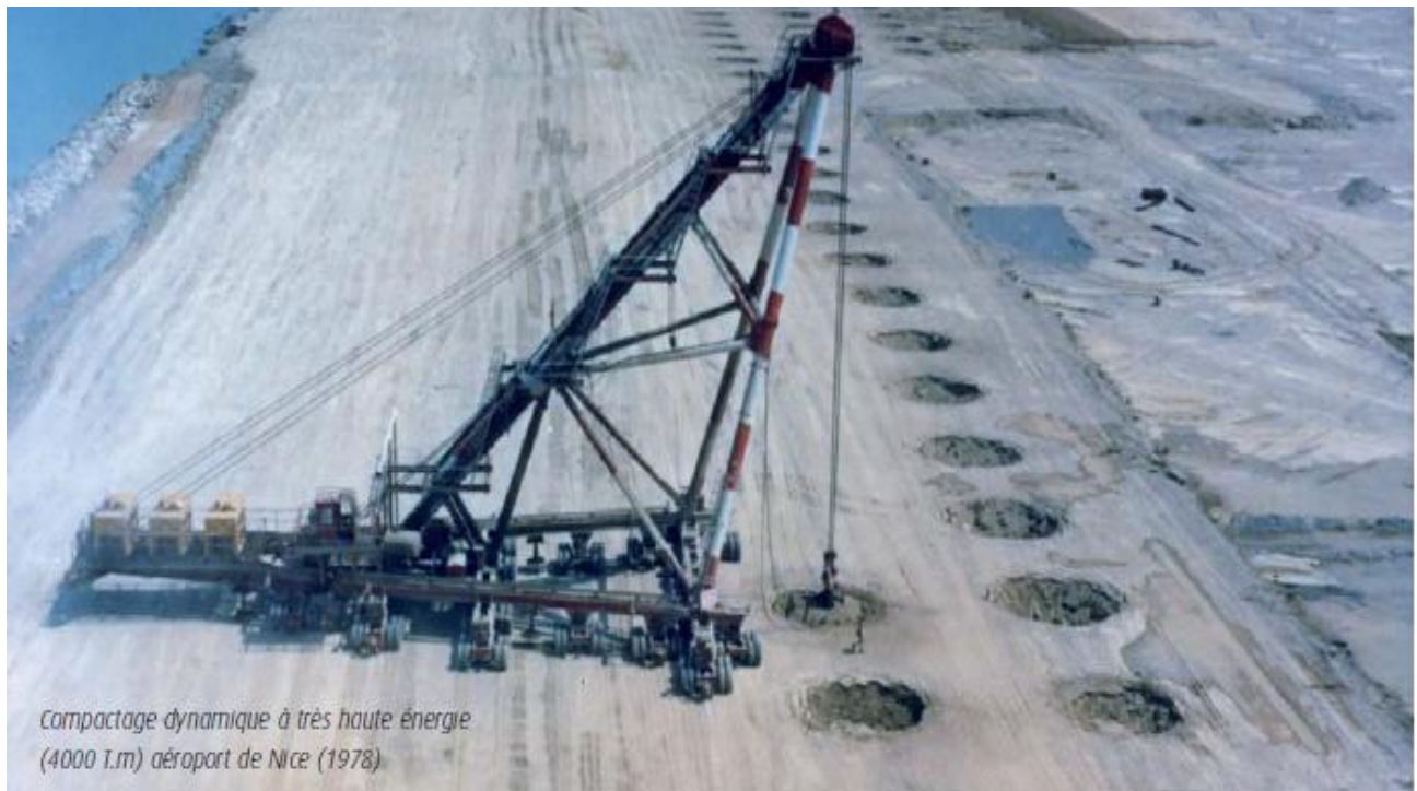
Figure 1 : Densification d'un terrain par compactage dynamique à très haute énergie (Cas réel de l'aéroport de Nice 1978, France).
