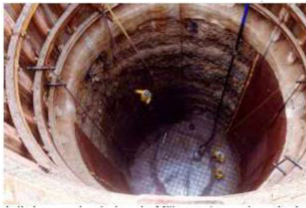
Fig. 3.1 puits avant mise en place des armatures
