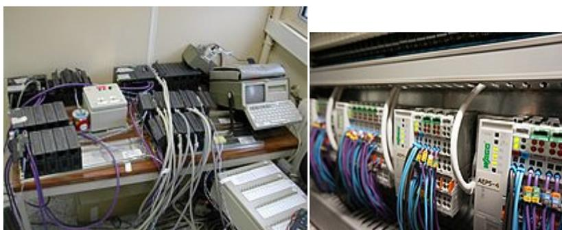
Deux automates programmables industriels & leurs périphériques, montés en volant, pour test et analyse. Automate industriel WAGO pour un système de monitoring en industrie pharmaceutique.
