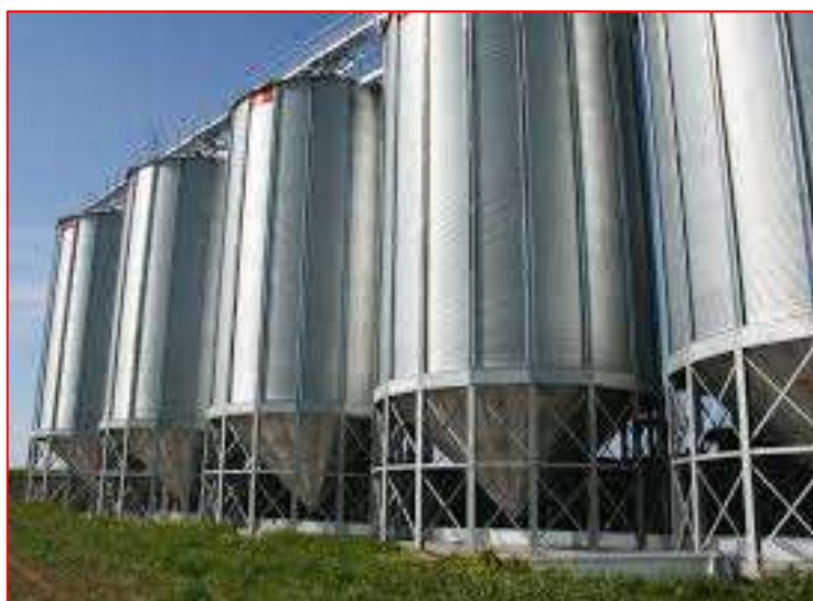
Figure 5.4 : Silos à fond conique
