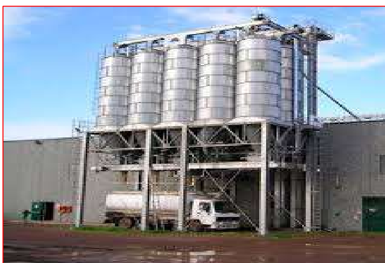
Figure 5.6 : Les boisseaux de chargement sur structure
