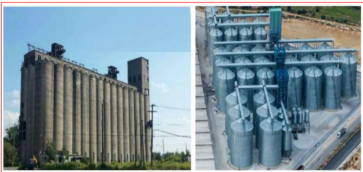
Figure 5.2 : Plusieurs silos accolés
