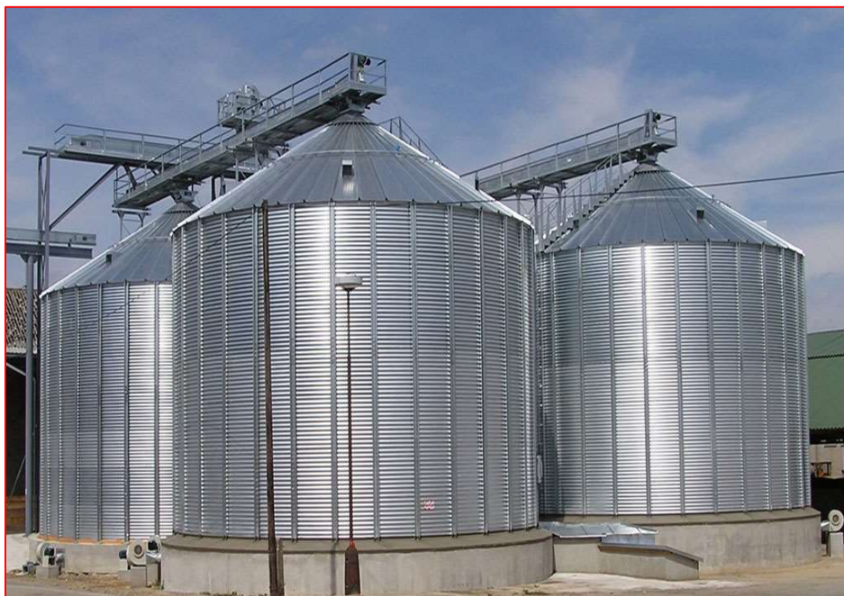
Figure 5.3 : Silos à fond plat
