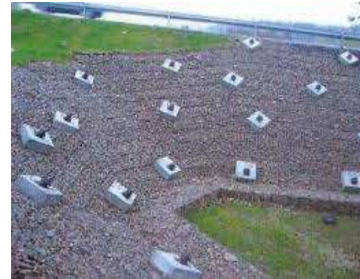
Talus maintenu avec des clou
