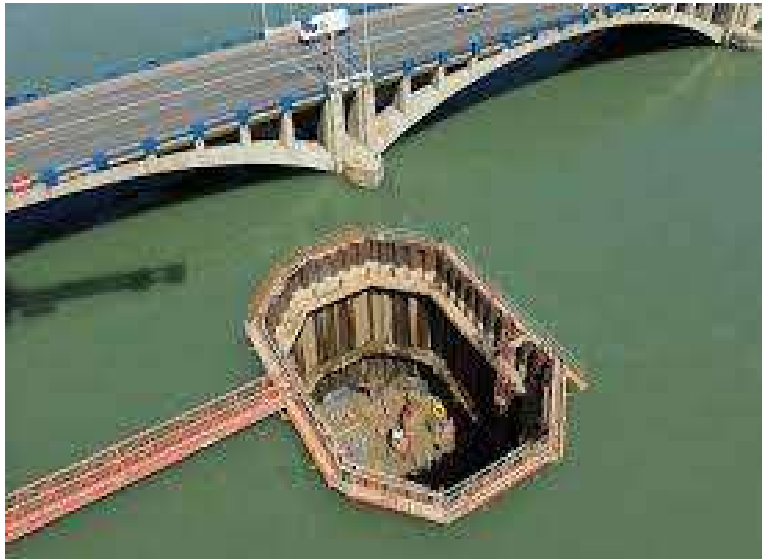
(02) Rideaux de palplanches (batardeaux) Pour réaliser une pile d'un Pont
