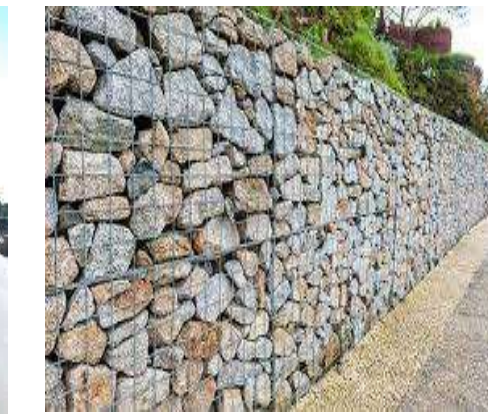
Mur en pierres (Gabions)
