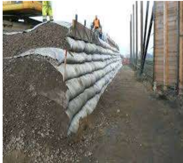
Ouvrages en terre renforcés par géotextiles
