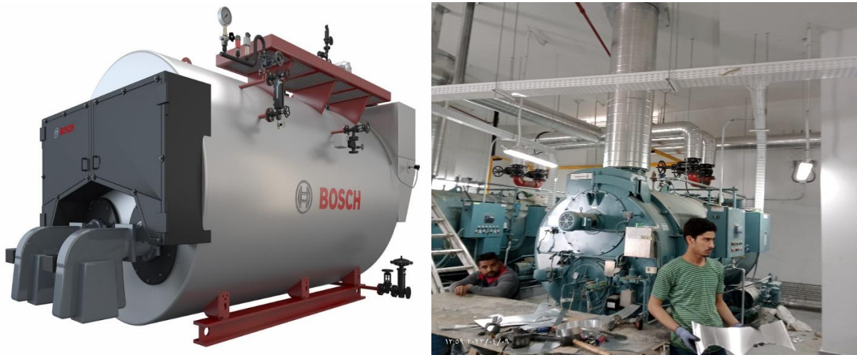
Figure : Chaudière vapeur à tubes de fumées.
