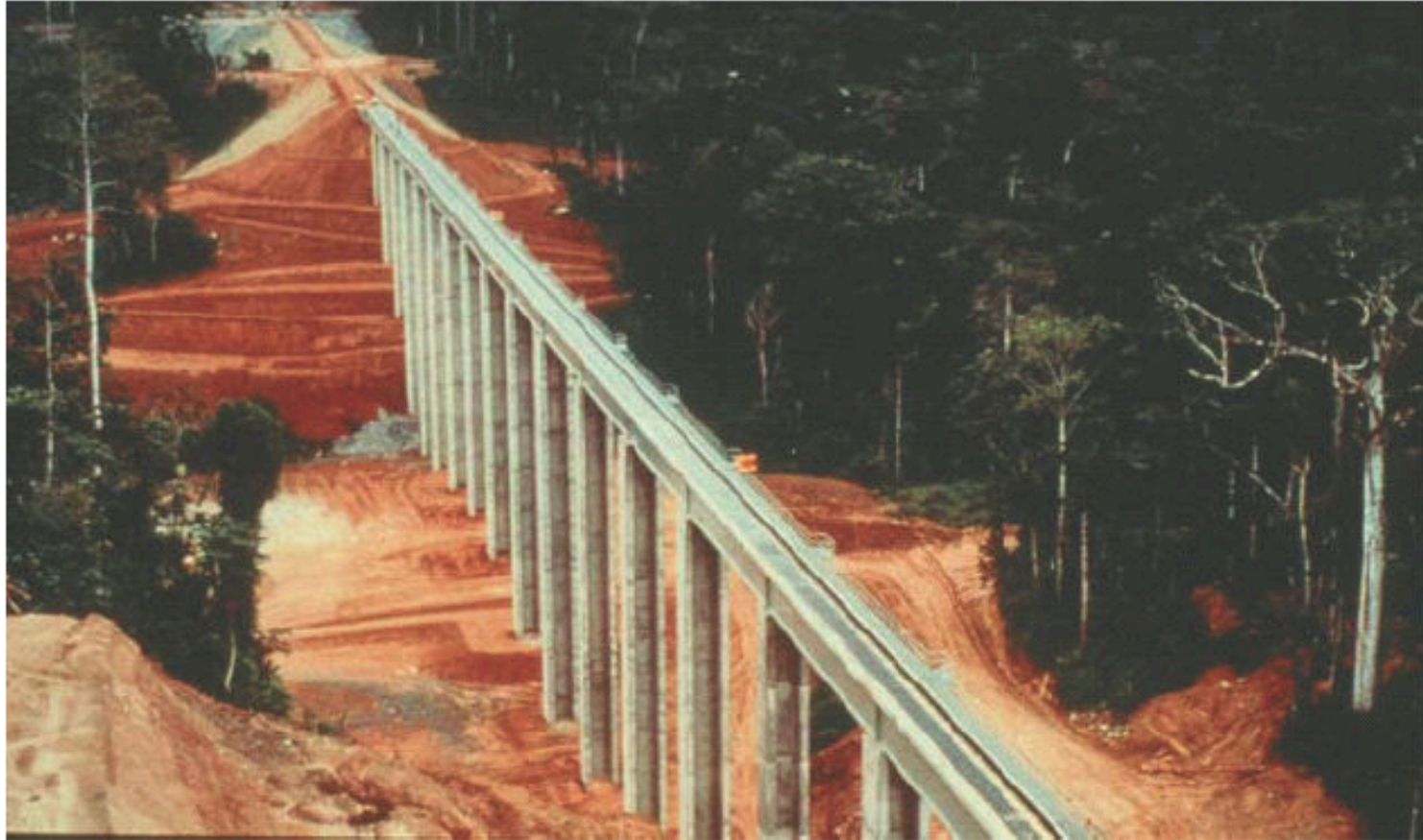
Viaduct en Cameroon utilisation de ciment avec fumée de silice importé du Canada - pour amélioration d'étanchéité
